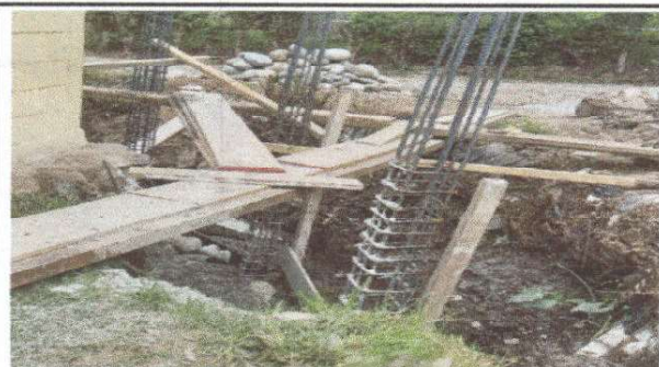
Foto 3: Construcción de muro.
