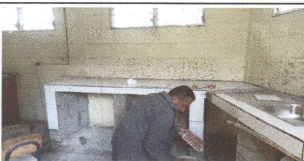
Foto 5: Construcción de lavatrastos y gabinetes.
