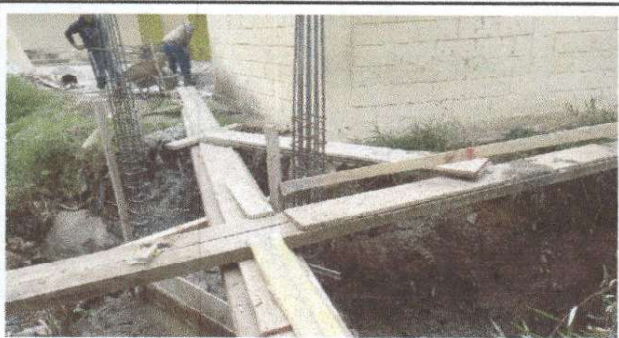
Foto1: Construcción de muro de contención para evitar inundaciones y deslizamientos de las instalaciones.
