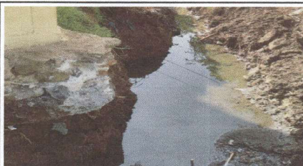
Foto 2: Trabajos preliminares para evitar el deslizamiento del área de cocina.
