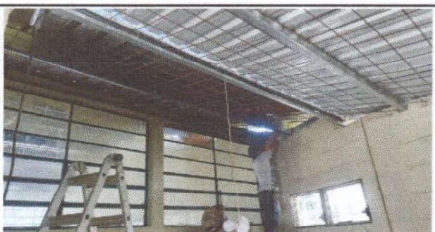
Foto 6: Colocación de instalación eléctrica (iluminación y enchufes eléctricos).
